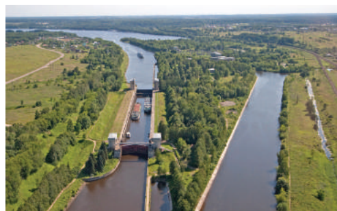
Шлюз №6 канала им. Москвы, пос. Икша
