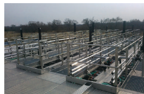
Очистные сооружения в Мамоново
